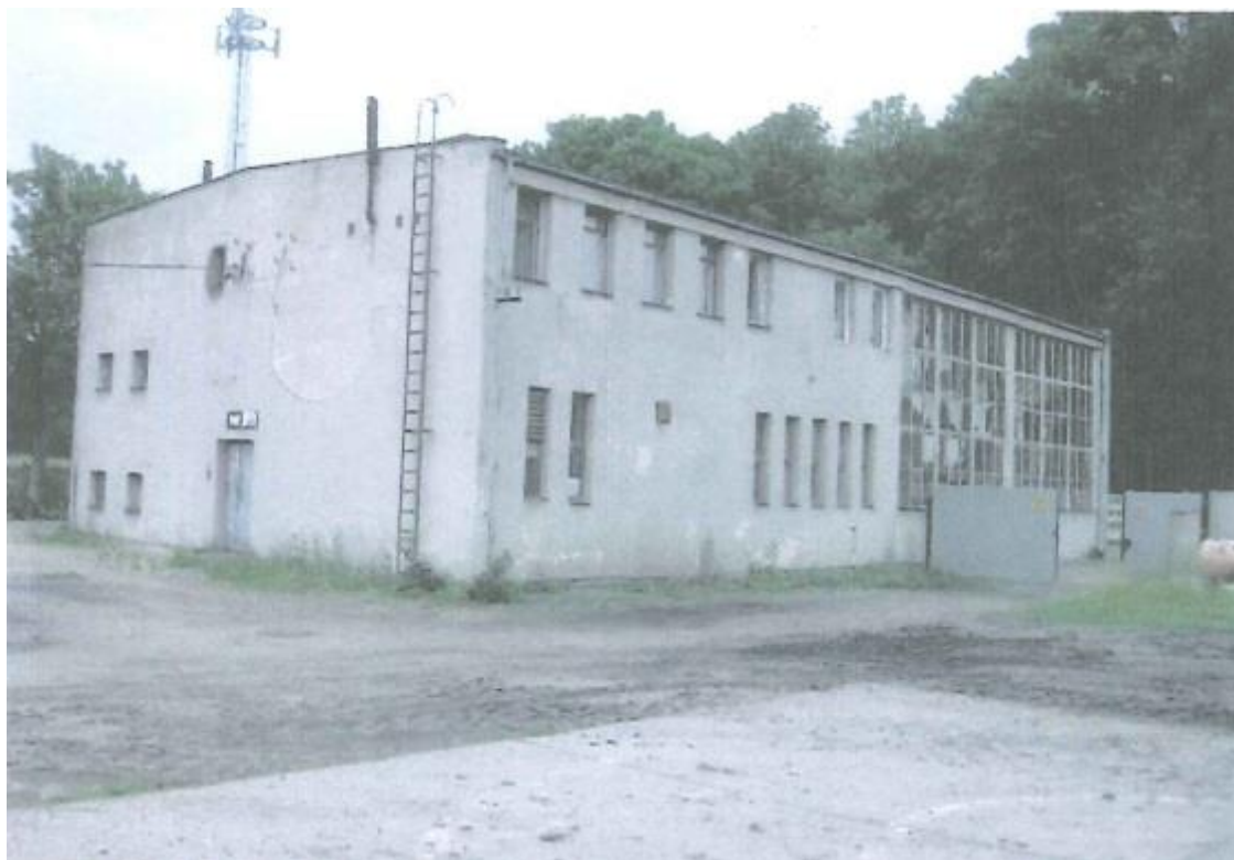
Fotografia 1. Poprzemysłowy budynek w Skrwilnie przy ul Targowej – przestrzeń zdegradowana.
